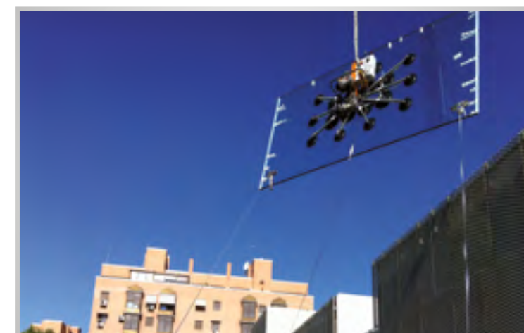
Instalación vidrios grandes dimensiones
