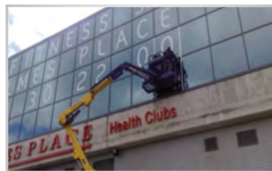
Instalación con cesta articulada
