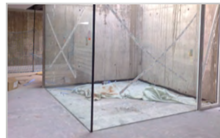
Instalación vidrios grandes dimensiones
